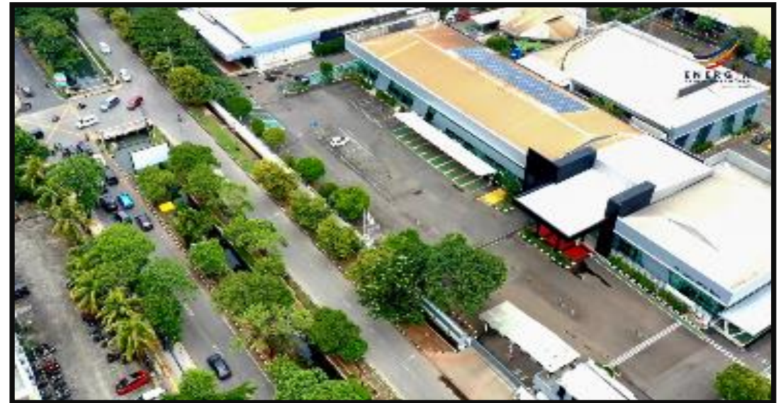
Solar PV yang telah dipasang pada Gedung Toyota Astra Motor Sunter
