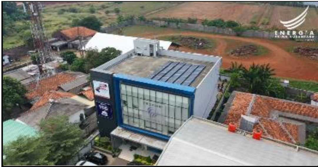
Solar PV yang telah dipasang pada Gedung Cabang Federal International Finance
