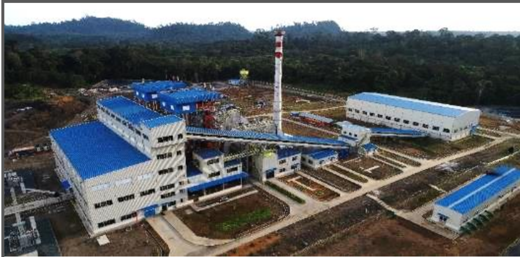
PLTU PAMA-1 2x15 MW Lokasi : Barunang Kalimantan Tengah Mulai beroperasi pada bulan September 2018
