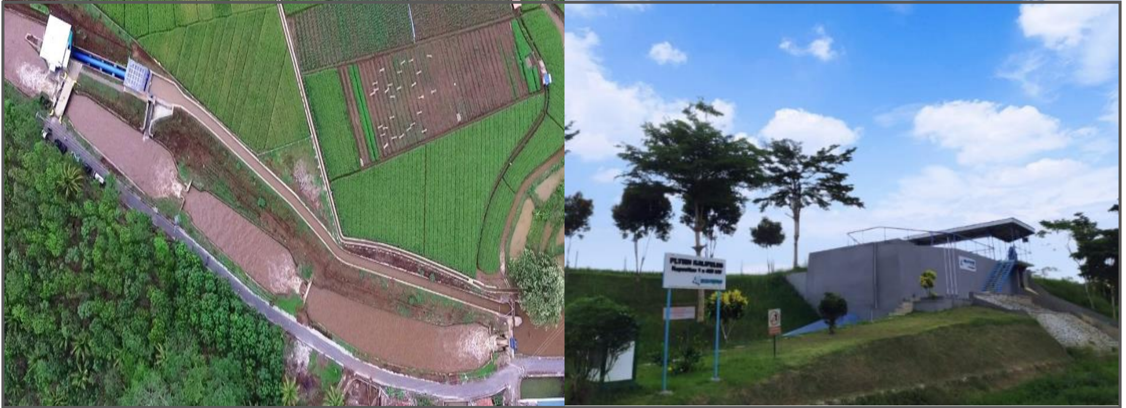
PLTMH Kalipelus 1 x 0.45 MW Lokasi : Kalipelus, Banjarnegara, Jawa Tengah Mulai beroperasi pada Februari 2017
