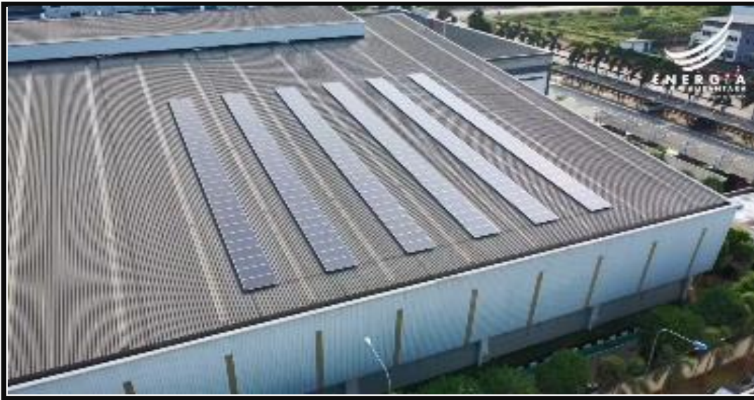
Solar PV yang telah dipasang pada Gedung Astra Daihatsu
